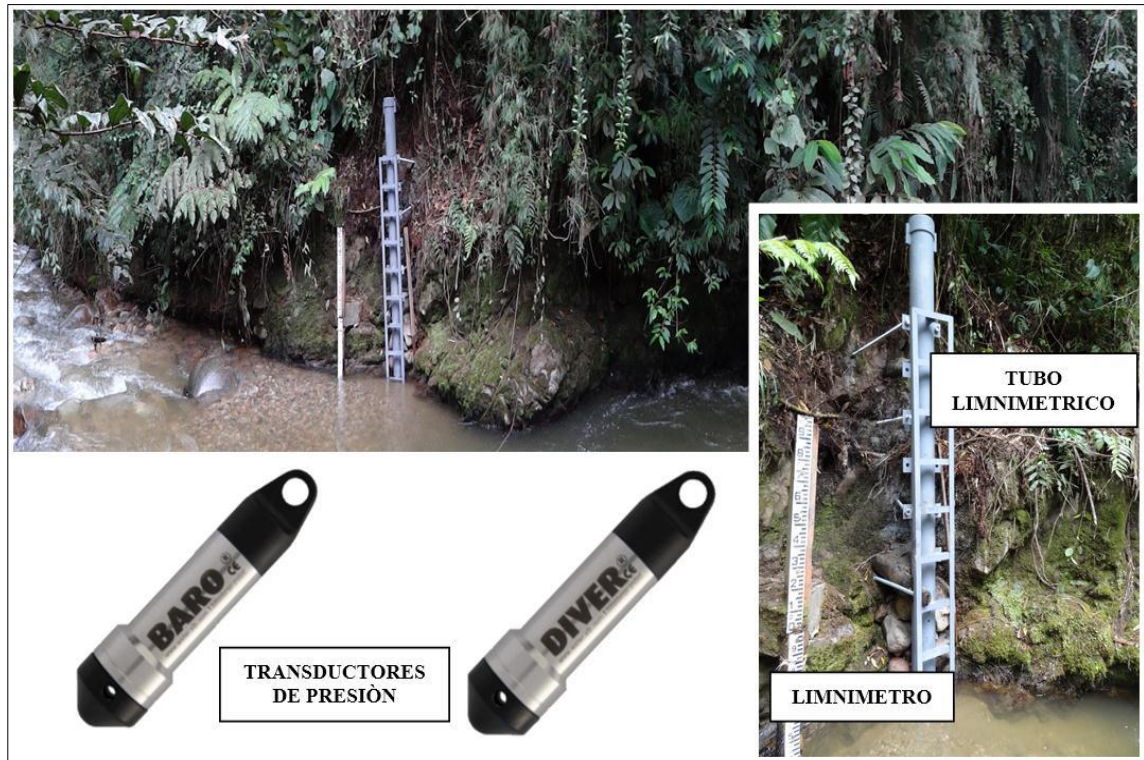
Figura 4. Estación automática de niveles El Rasgón
